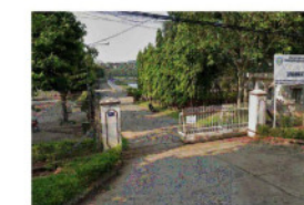
TRẠM XLNT BUỒN MÊ THUỘT
