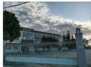
TRẠM BƠM NƯỚC THỎ NHÀ MÁY NƯỚC EA NA
